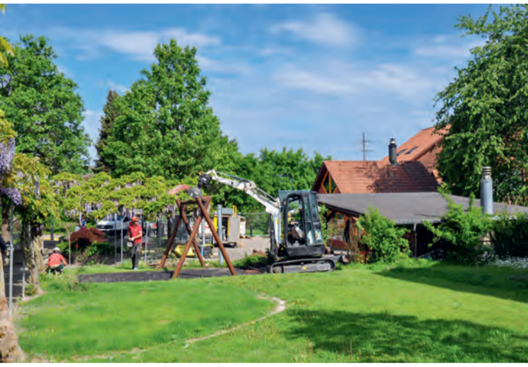
Baubeginn. Als erstes werden die alten Spielgeräte demontiert.
