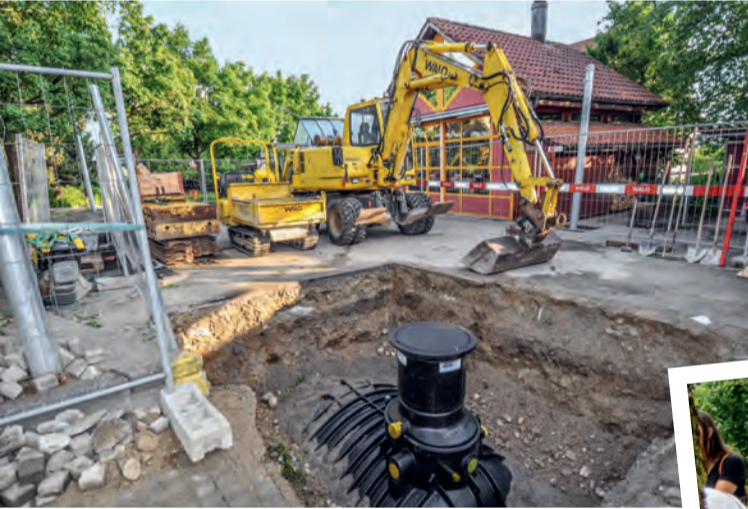
Damit Wasser für die Spielgeräte zur Verfügung steht und wiederverwendet werden kann, wird der grosse Wassertank im Boden eingesetzt.
