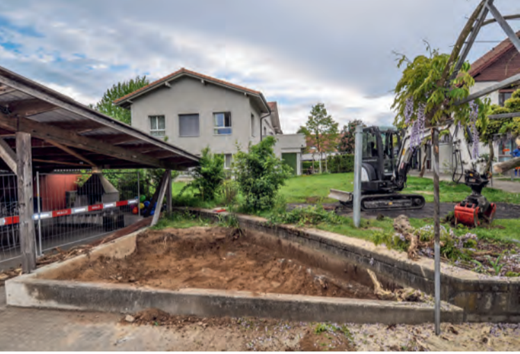
Es folgen die Aushubarbeiten für das untere Wasserbecken.
