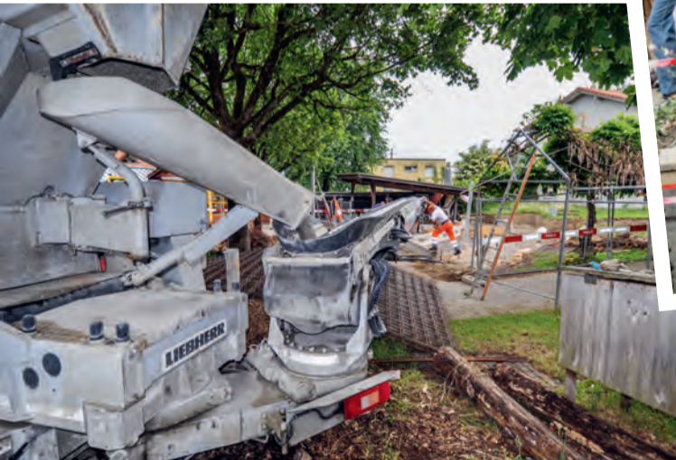
Der Beton wird auf dem Förderband an Ort und Stelle gebracht.
